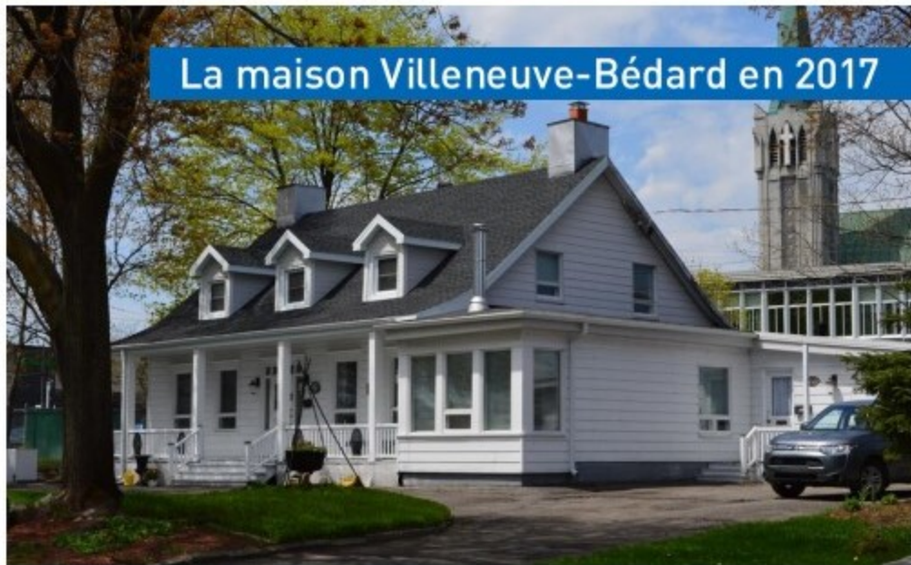
La maison Villeneuve-Bédard de la 46 e Rue Est comme elle était en 2017. (Photo : Ville de Québec)
